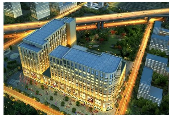
杭政储出【2011】59号地块商业金融用房改造项目 （加固改造） 建筑面积：74896.93平方米 建筑功能：宾馆、商业 结构形式：框架结构 结构改造：1、增设钢结构夹层；2、增设自动人行道、自动扶梯；3、增设钢结构夹层； 4、裙房顶层拔除两颗框架柱，通过钢筋混凝土预应力大梁托换，跨度由8.4m增加至25.2m； 5、二层增设游泳池。
