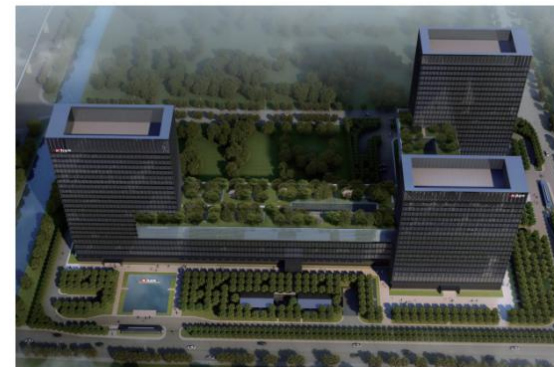
大华智慧安防（物联网）生产基地 （结构设计） 建筑面积：250000平方米 建筑功能：高精密研发厂房 结构形式：框架-剪力墙结构
